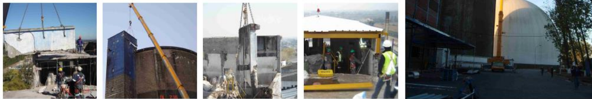
Ilustración 10: Reparaciones Silo Lucks Planta Cocharcas, Iansagro S.A, Chillán. Fuente: Presentación de la empresa.
