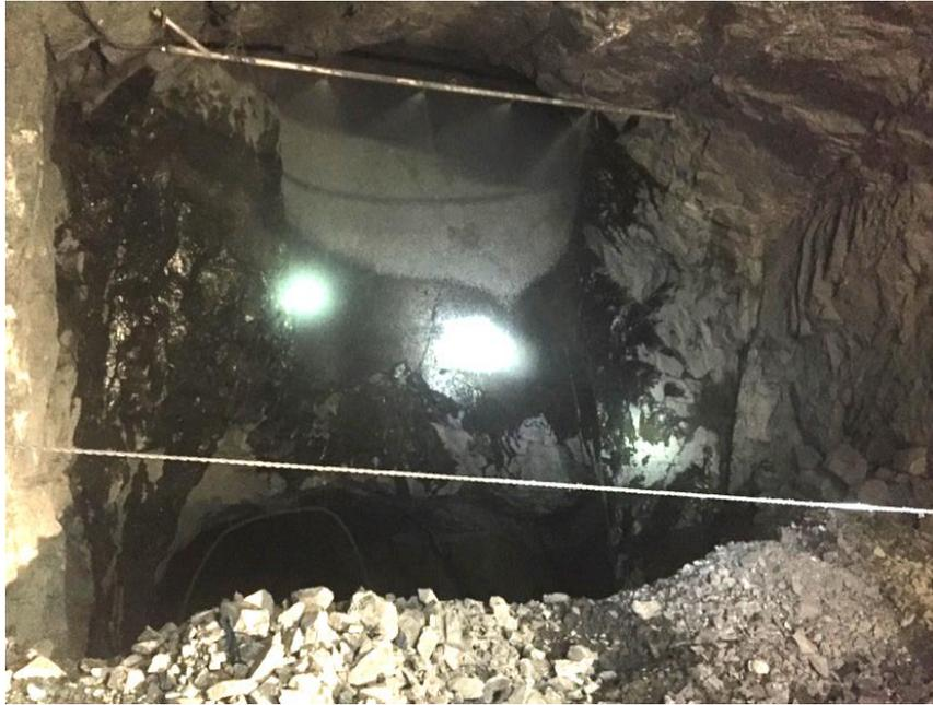
Figura 4-2. Sistema de Humectación de Chimenea de Traspaso Nivel 750.
