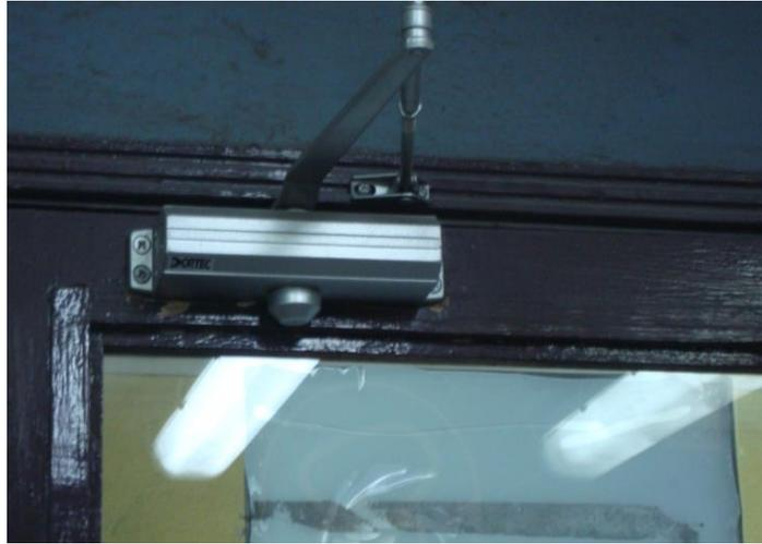
Figura 4-11. Brazo Hidraulico.
