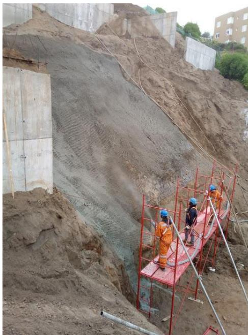
Figura 2- 38 Instalación de shotcrete.
