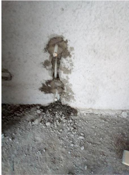
Figura 2- 36 Conexión para la futura instalación de radiador.
