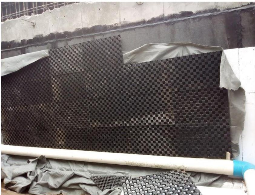
Figura 2- 34 Instalación de Geotextil para la captación de aguas subterráneas.
