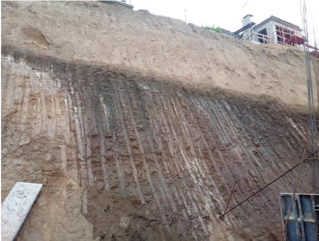
Figura 2- 42 Corte realizado para muros de contención sector D. Con la napa a captar.
