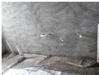
Figura 2- 32 Tuberías de alcantarillado baño por sobre losa.
