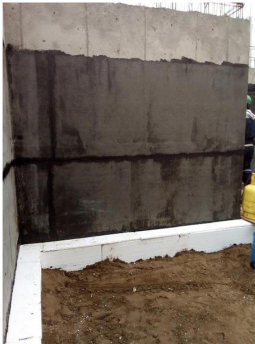
Figura 2- 32 Membrana instalada en muro contra terreno.
