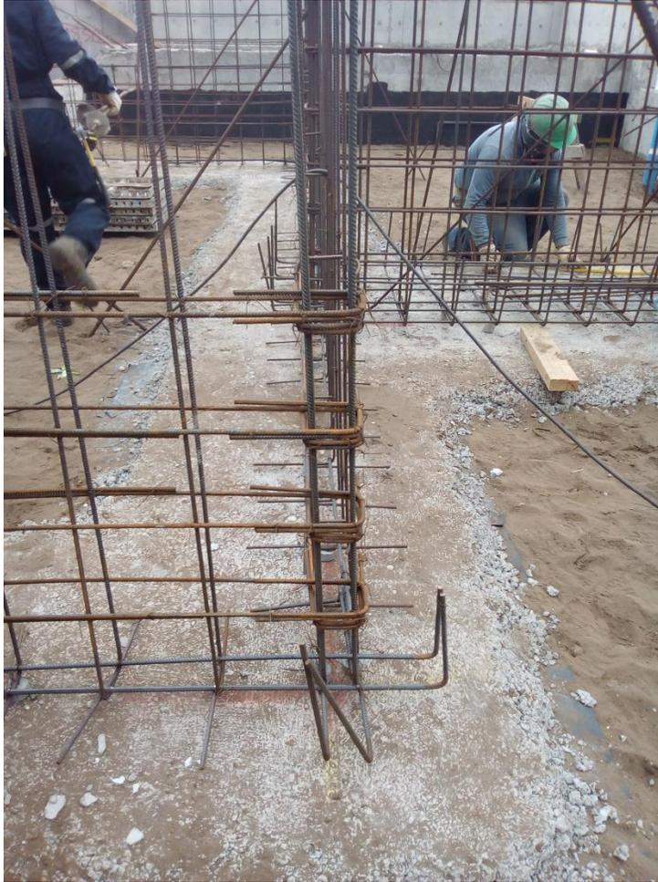
Figura 2- 43 Enfierradura de muros puestos en emplantillado..
