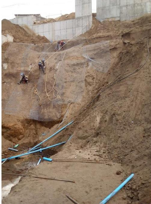
Figura 2- 37 Instalación de malla para futuro shotcrete.
