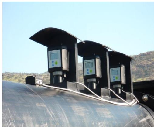
*Figura 18: Sensores ubicados en tubería luego del lavador de gases (Elaboración propia).*
