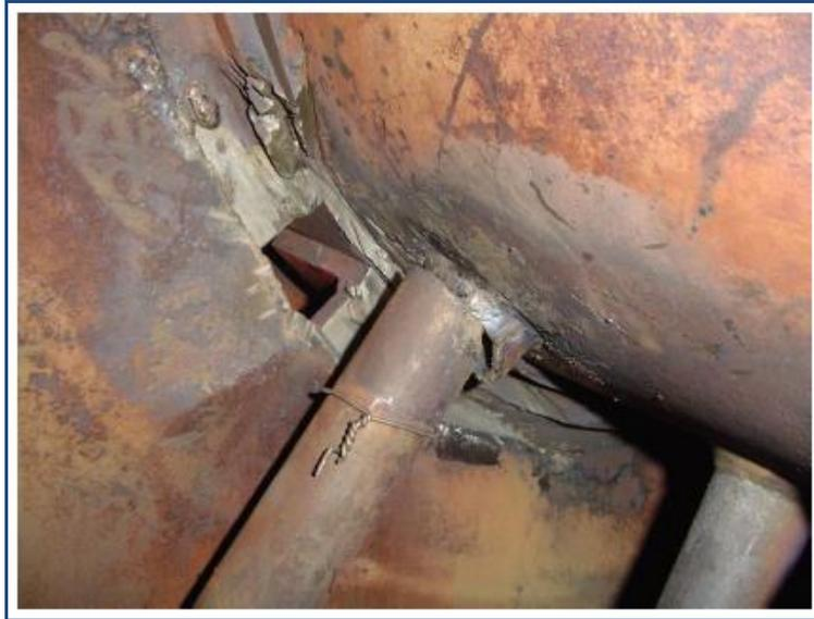
Figura 6.7 Rotura en cabezal de vapor producto de fatiga térmica. Fuente: Flexibility conference Chile, Engie lab.
