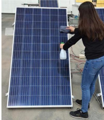
*Figura 6-2: Procedimiento de limpieza de módulos fotovoltaicos.*
