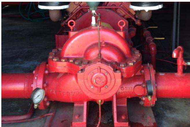
Figura 6 Imagen de bomba del SCI
