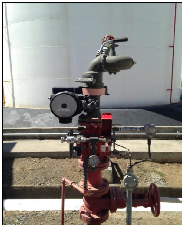
Figura 8 Monitor de refrigeración de estanques
