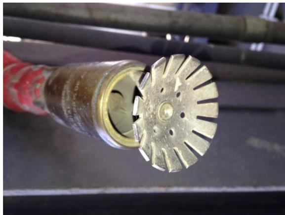
Figura 7 Imagen de Sprinkler en mesas de carga
