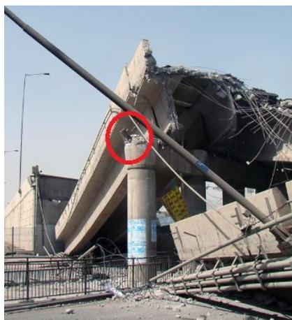
Figura 2-11. Tope sísmico de acero en PS Lo Echevers luego del terremoto del Maule (2010)
