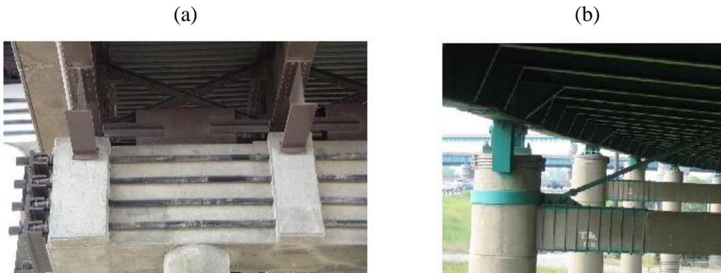
Figura 2-36. Reforzamiento sísmico del cabezal; (a) Barras postensadas en puente “Poplar Street Complex”, estado de Missouri; (b) Reforzamiento de corte, confinando extremos del cabezal con placas metálicas en puente “Poplar Street Complex”, estado de Illinois
