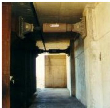
Figura 2-38. Disipadores viscosos en Puente Amolana
