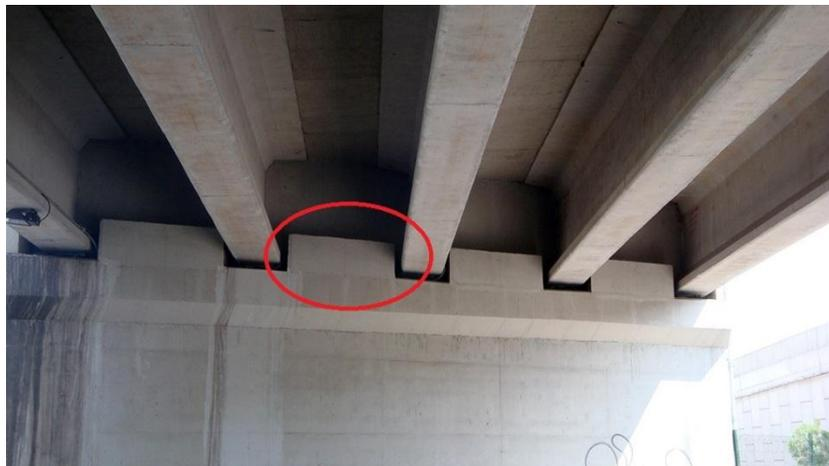
Figura 2-9. Tope sísmico de hormigón armado en estribo
