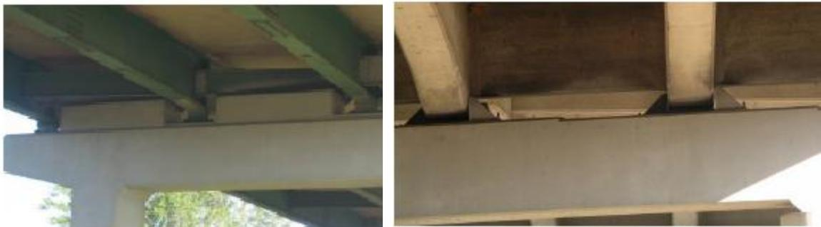
Figura 2-34. (a) Topes laterales de hormigón en puente (SR59 over I40), estado de Tennessee; (b) Topes laterales de acero (Chambers Chapel Road), estado de Tennessee
