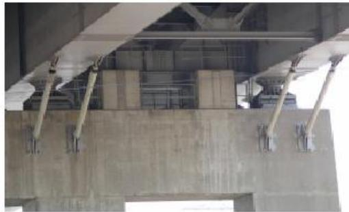
Figura 2-33. Dispositivo de amortiguación viscoso en puente “Poplar Street Complex”, estado de Missouri
