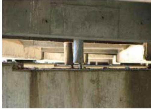
Figura 2-17. Dispositivo de disipación metálico
