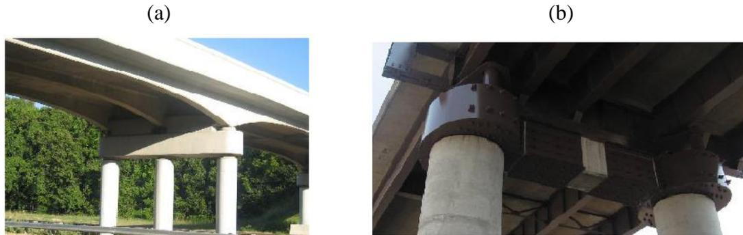
Figura 2-37. Reforzamiento estructural de viga en estado de Missouri, EEUU; (a) Encamisado de hormigón; (b) Encamisado de acero
