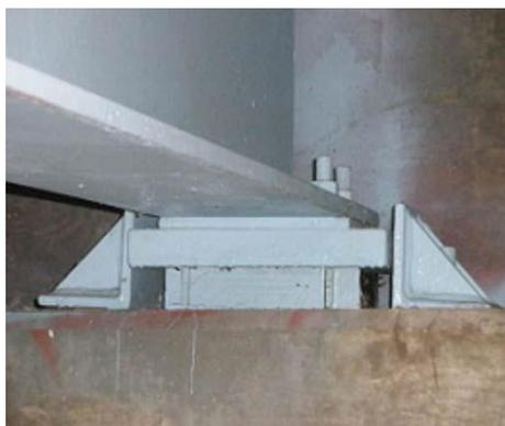
Figura 2-10. Soporte de apoyo usado en placa de apoyo elastomérica en puente en el estado de Indiana, EEUU
