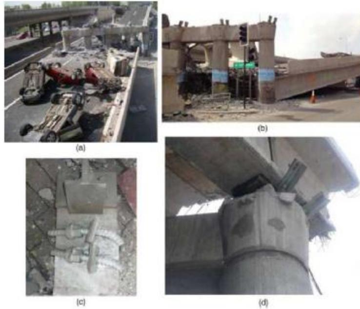
Figura 1-2. Colapso de PS Superior; (a) Tableros colapsados; (b) Tableros colapsado, donde se aprecia columnas sin daños; (c) Tope sísmico de acero dañado; (d) Topes sísmicos de acero y apoyos elastoméricos desplazados
