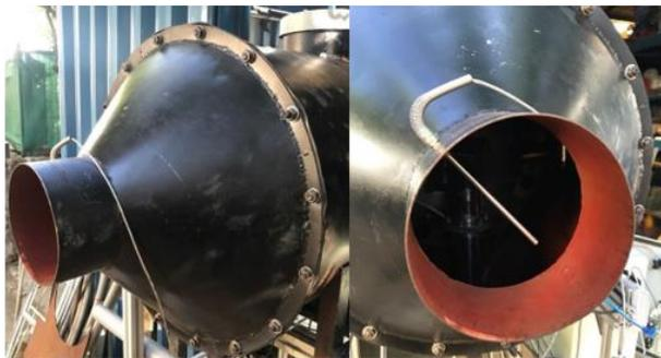
Figura 49: Instalación PT-100 en cono de descarga.
