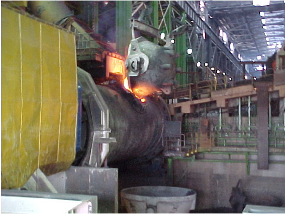
Figura 5-2: Nave de fundición
