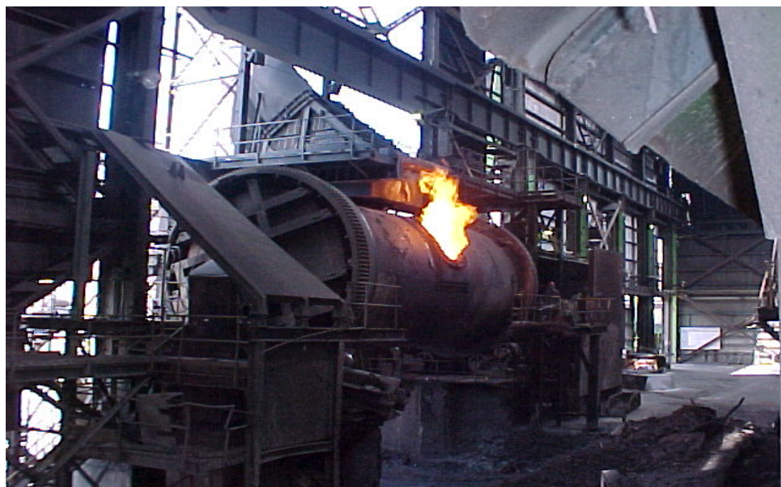
Figura 8-8: Horno Limpieza de escoria
