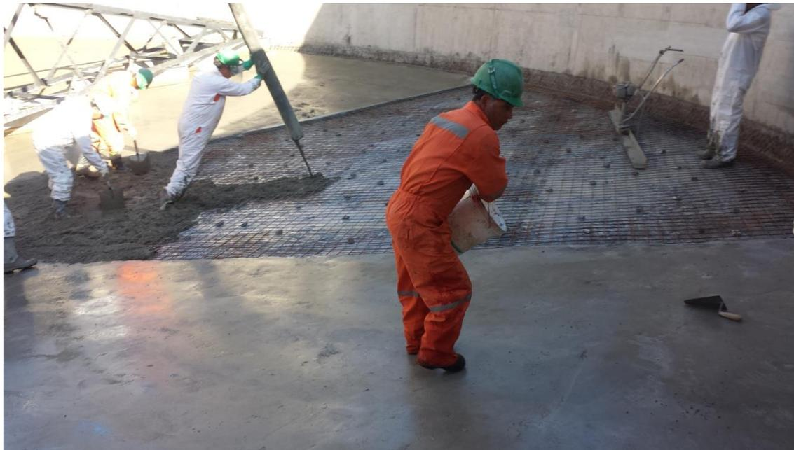
Figura 2-35 hormigonado y constante hidratado de lo losa ya construida(fuente: foto tomada durante la práctica)
