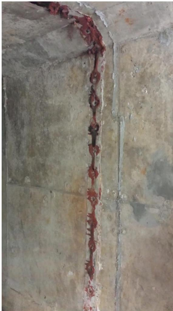
Figura 2-19 Retirar Sikawell adherido al hormigón(fuente: foto tomada durante la práctica)
