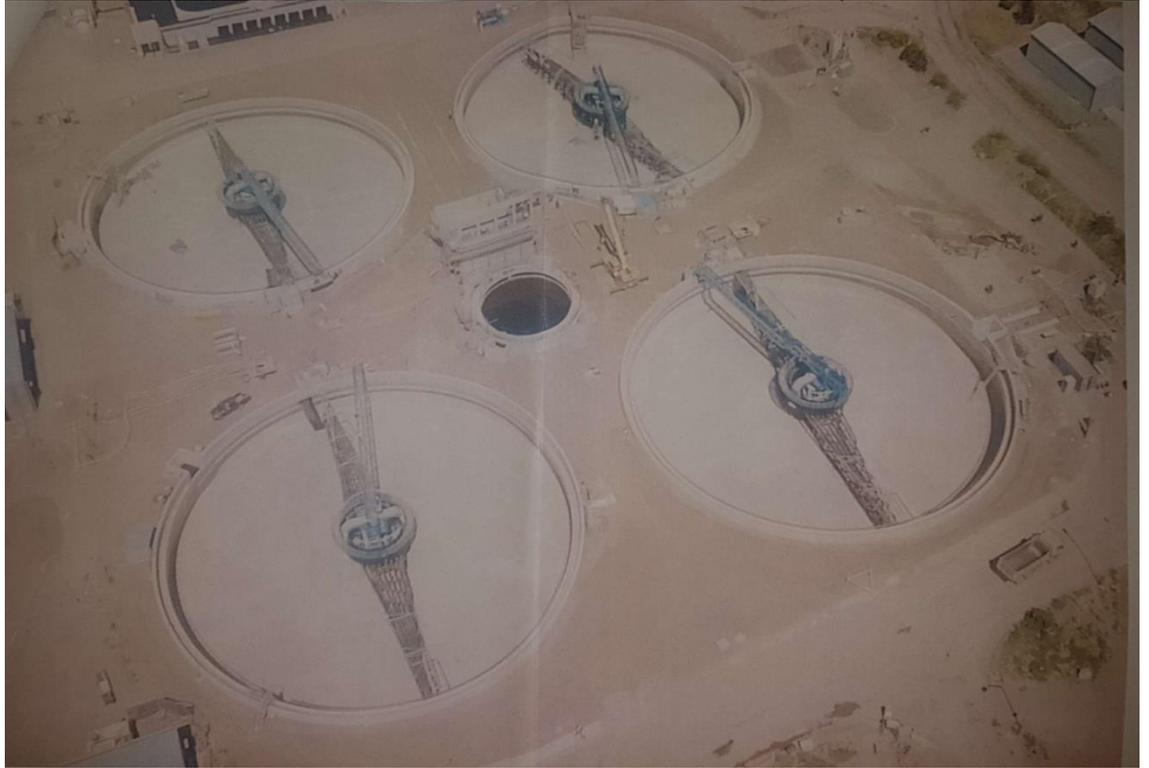
Figura 1-8 Clarificadores secundarios en proceso de construcción(fuente:fotos del proceso)
