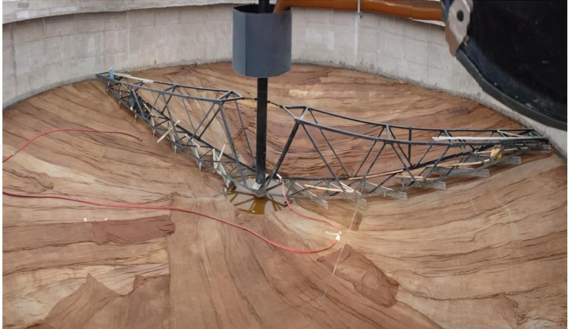
Figura 2-37 Losa completamente hormigonada y tapada con arpilleras(fuente: foto tomada durante la práctica)
