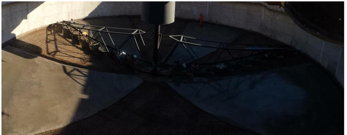
Figura 2-34 Espesor de lodo antes de ser hormigonado(fuente: foto tomada durante la práctica)
