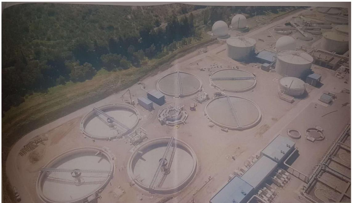
Figura 1-9 Clarificadores primarios en proceso de construcción(fuente: fotos de proceso)
