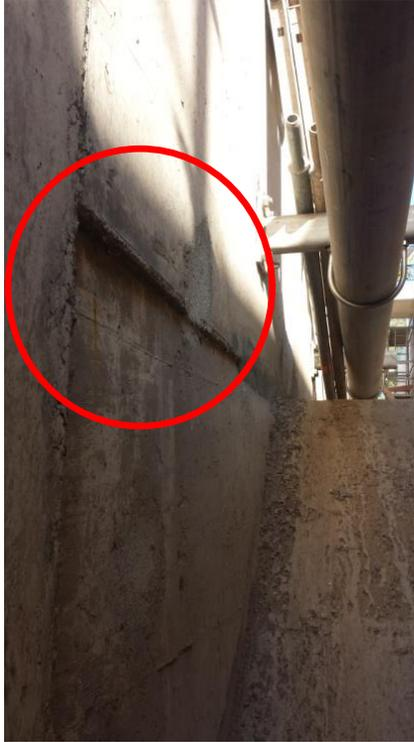
Figura 2-18 Mejorar terminación sector seleccionado en estaque de aireación(fuente: foto tomada durante la práctica)
