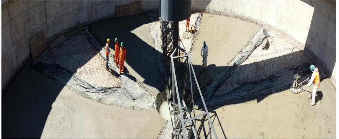
Figura 2-1 Alisado de espesador de lodo mediante helicóptero(fuente: foto tomada durante la práctica)
