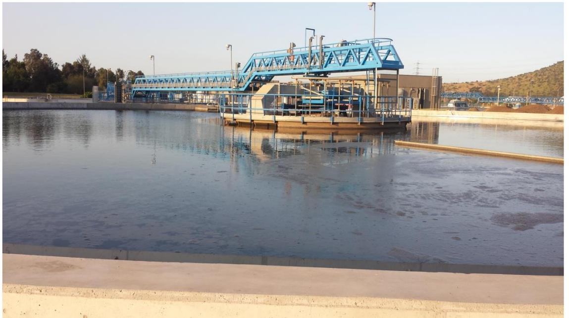
Figura 2-7 Clasificador secundario en funcionamiento(fuente: foto tomada durante la práctica)
