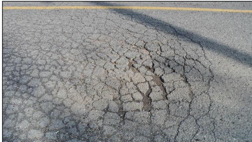
**Figura 2-10 Deterioro por fatiga de calzada [33]**
