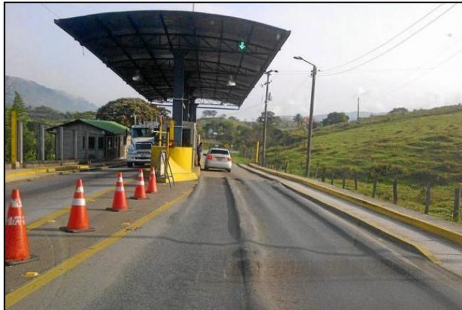
Figura 2-7 Falla por ahuellamiento de calzada [33]
