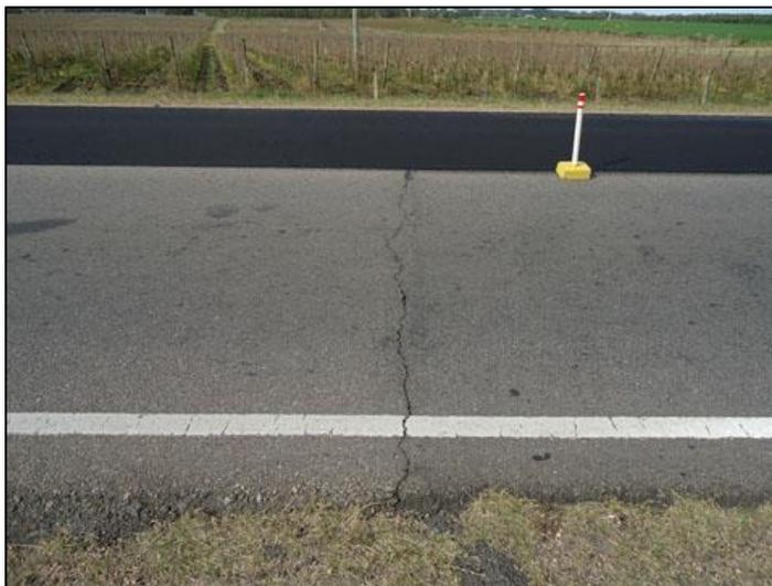
**Figura 2-11 Falla por agrietamiento térmico en pavimentos [34]**
