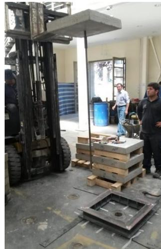
*Imagen 23: Extensión del perno de anclaje y traslado de panel.*
