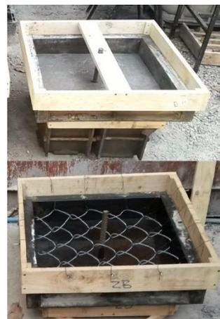
*Imagen 12: Molde de fierro con perno de anclaje y marco de madera.*
