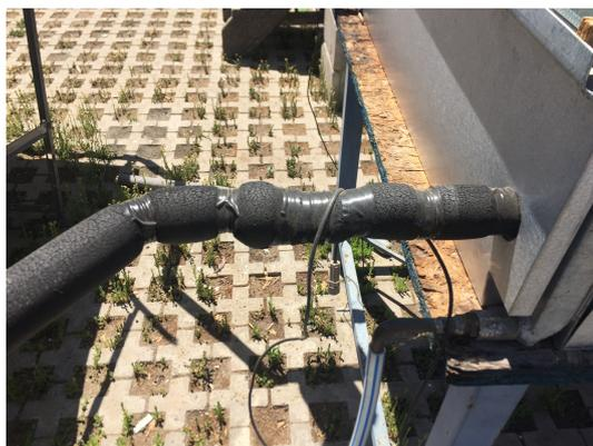
**Figura 7.4:** Tubo de termofluído, con su aislante
