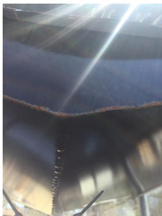
**Figura 7.2:** Óxido en la estructura, producto de soldadura
