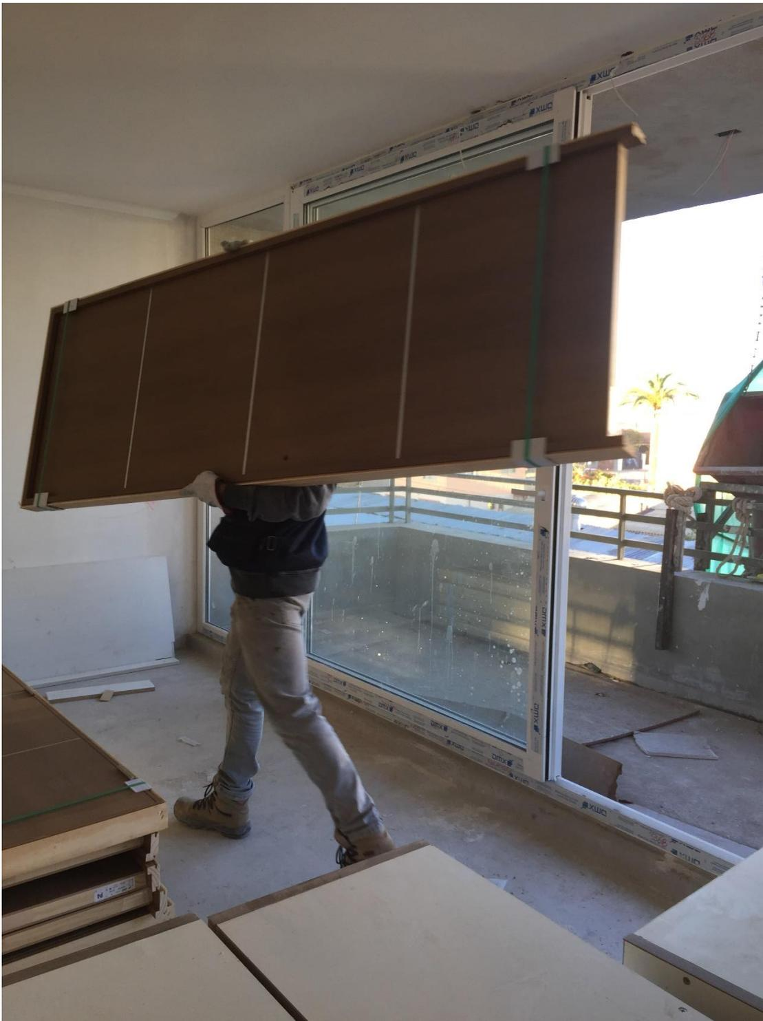
Figura 5-9: Carga asimétrica de la puerta sobre la espalda del trabajador.
