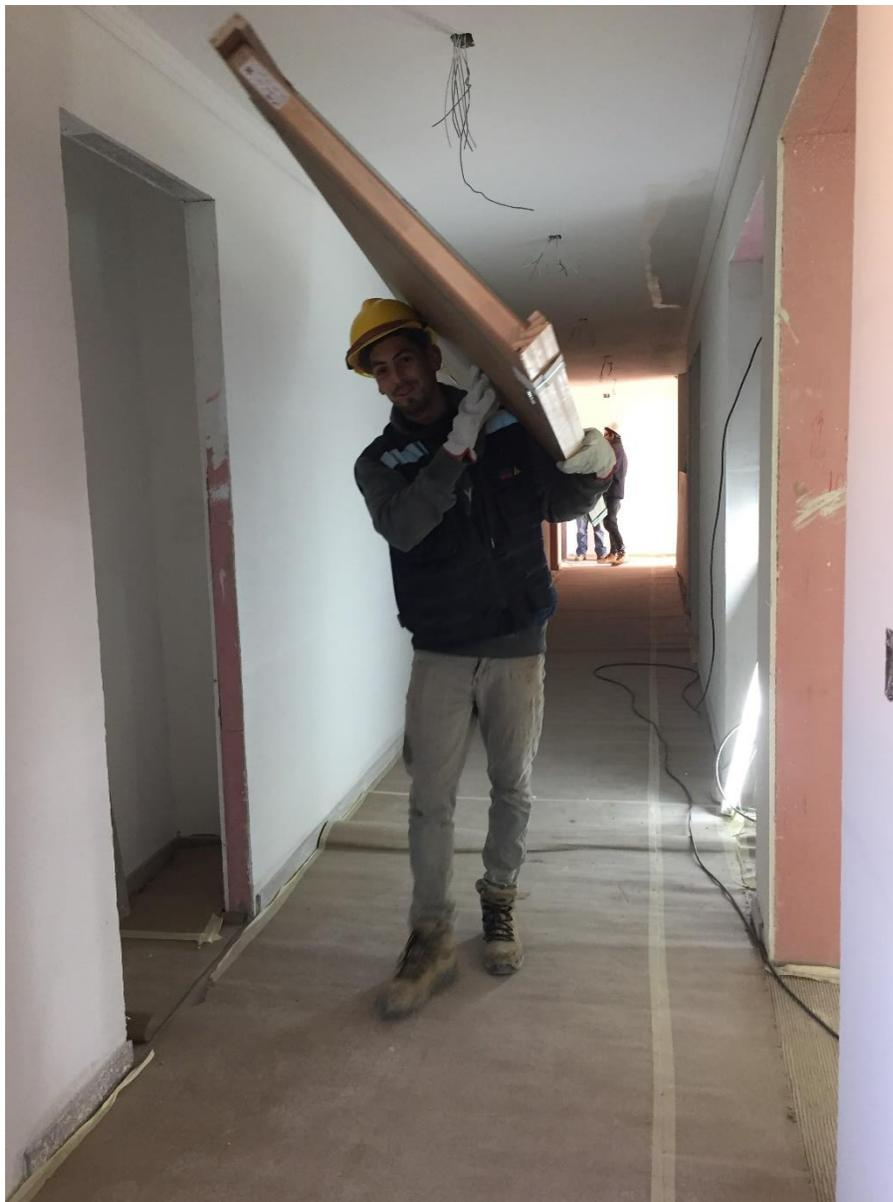
Figura 5-10: Carga asimétrica sobre la espalda del trabajador transportando la puerta
