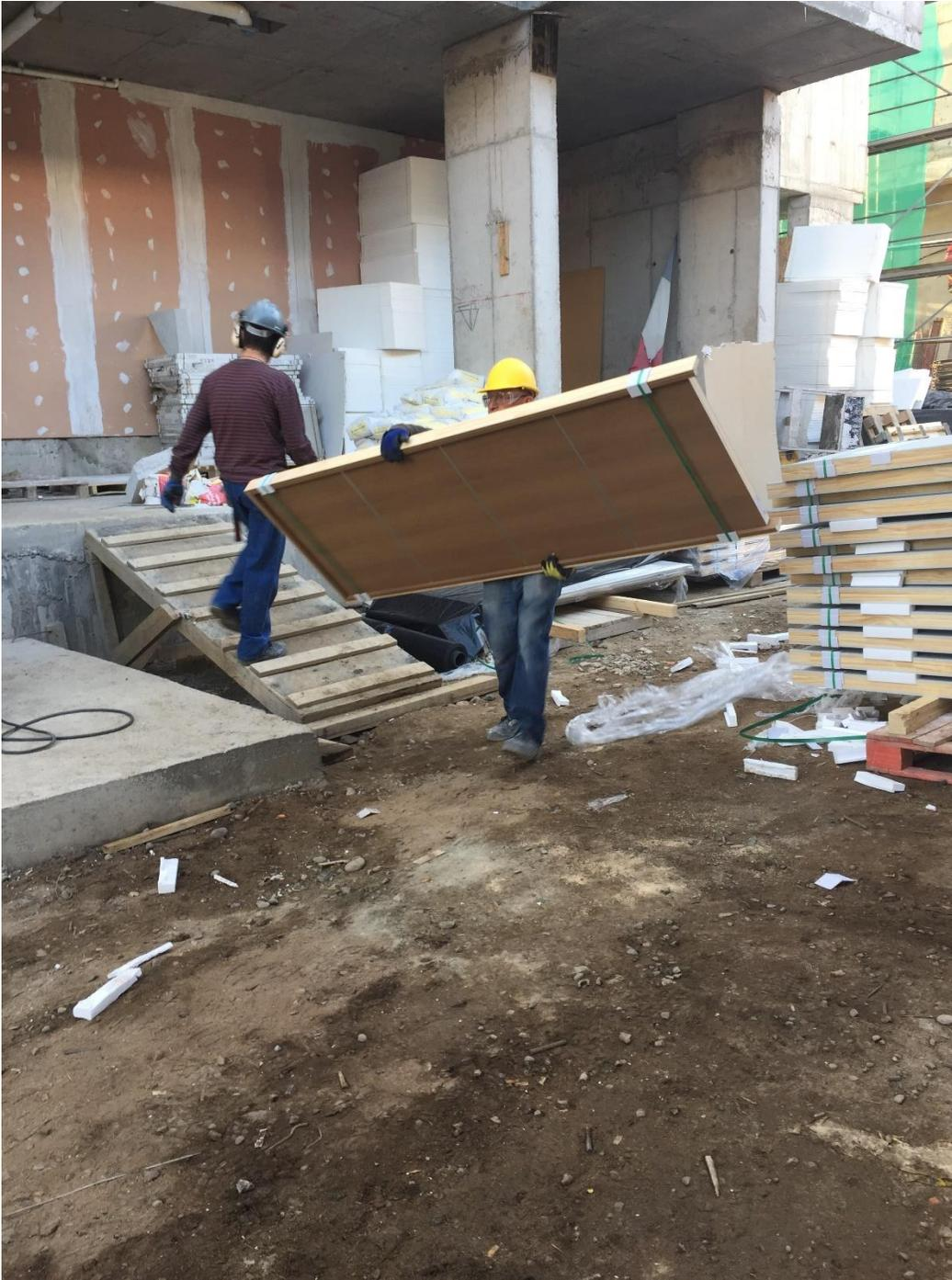
Figura 5-7: Carga asimétrica de la puerta sobre la espalda del trabajador
