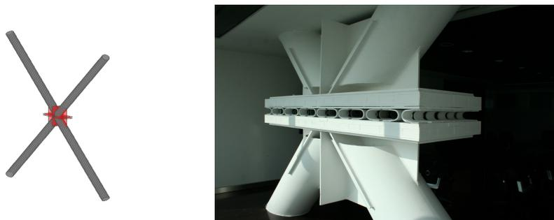
Figura 10.6: Disipadores Transversales
