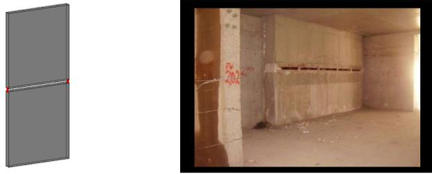
Figura 10.7: Disipadores Longitudinales
