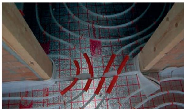
Figura 2.14 Juntas de dilatación y Funda aislante
