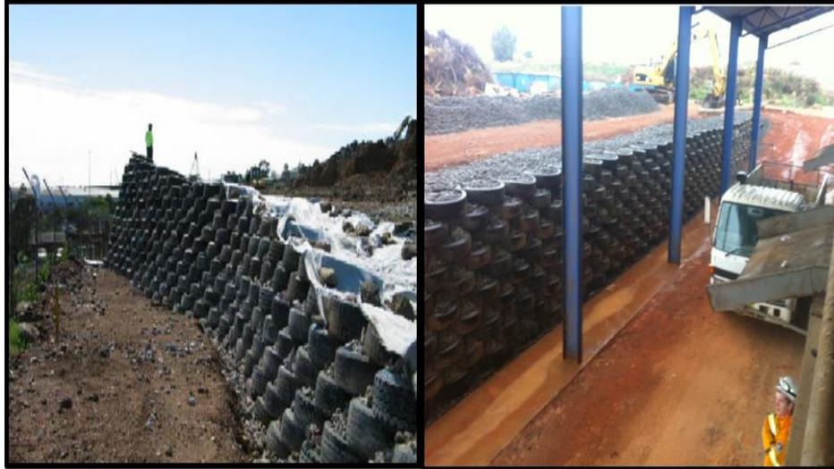
Figura 2.5 Taludes conformados por neumáticos en Nsw. Ecoflex Australia Plt (2005).
