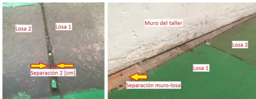
Figura 3.9: Detalles de construcción de la losa. Fotografía tomada en KRCC Santiago.
