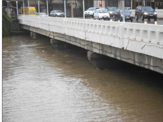
De acuerdo a los resultados de las simulación hidráulica la diferencia entre el nivel inferior de la viga del puente y el nivel de agua se produjo a las 15:00 hrs corresponde a  $DH=0.57$ (m), según puede apreciarse en el gráfico de la Figura 7-10.
