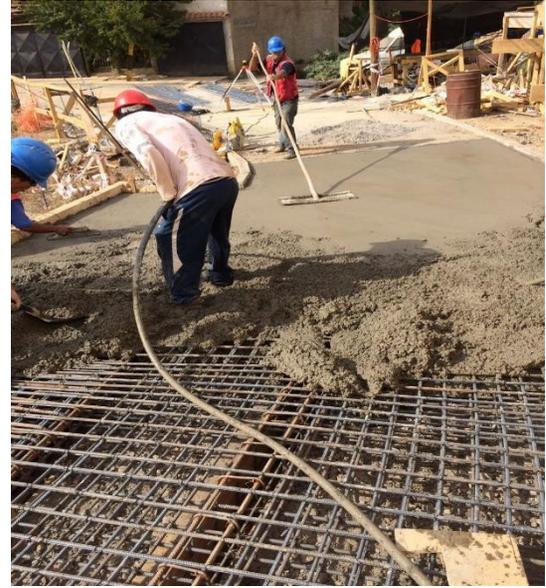
*Figura 21. Llenado de losa.*
