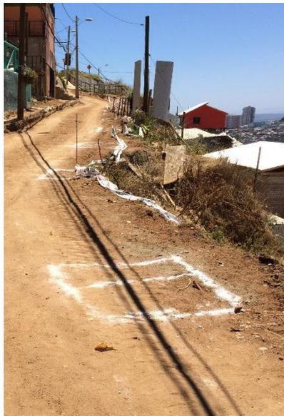
*Figura 16. Replanteo de losa.*
