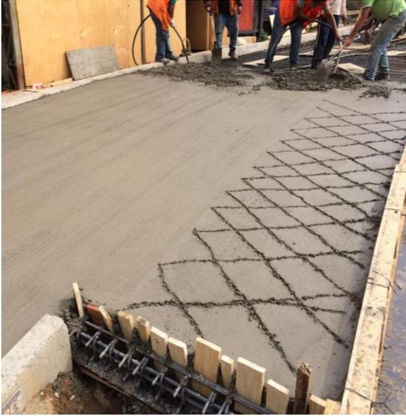
*Figura 20. Llenado de losa.*
