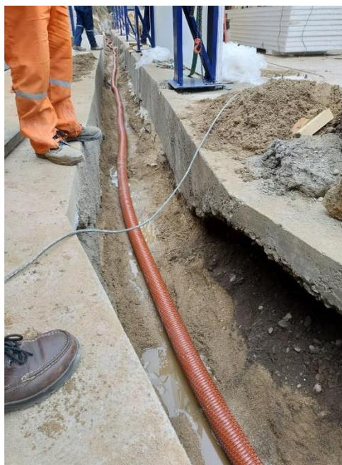
*Fuente: Obra “Galpón Safe Boats” / Ilustración 15: Colocación de Tubo de drenaje.*
