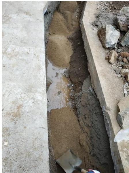
*Fuente: Obra “Galpón Safe Boats” / Ilustración 14: Llenado de zanja con arena.*
