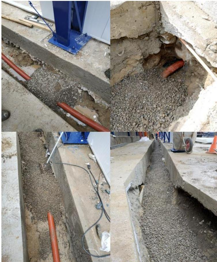
*Fuente: Obra “Galpón Safe Boats” / Ilustración 16: Secuencia de llenado con estabilizado.*
