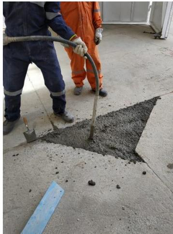
*Fuente: Obra “Galpón Safe Boats” / Ilustración 27: Vibrado de parches.*
