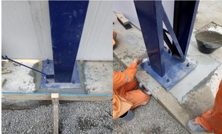
Fuente: Obra “Galpón Safe Boats” / Ilustración 33: Supervisión de Grout en pilares.
