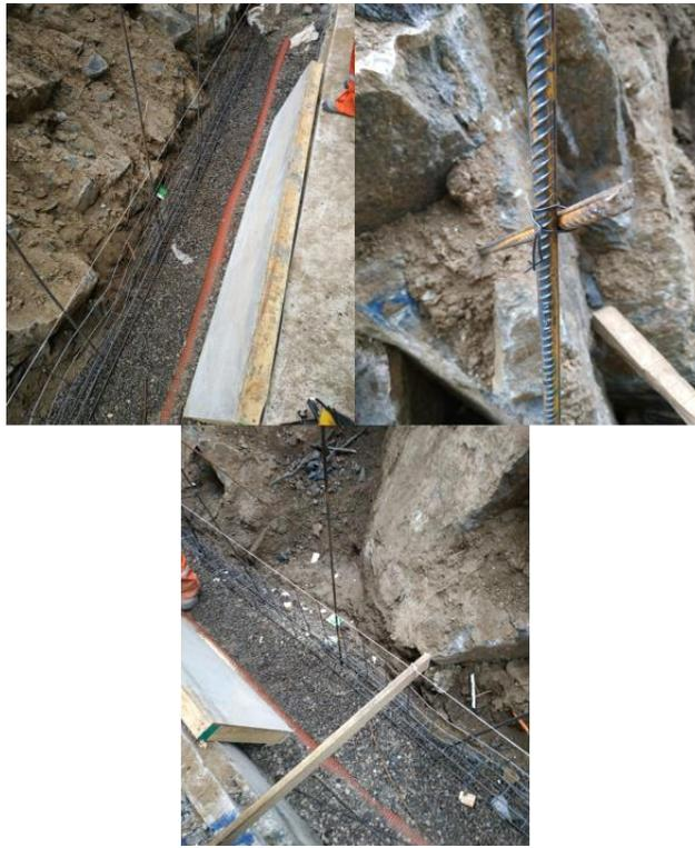
*Fuente: Obra “Galpón Safe Boats” / Ilustración 18: Enfierradura del murete de contención.*
