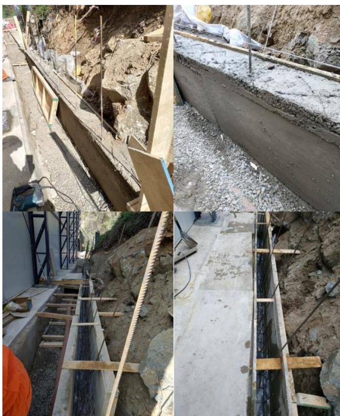
*Fuente: Obra “Galpón Safe Boats” / Ilustración 21: Secuencia de desmoldaje.*
