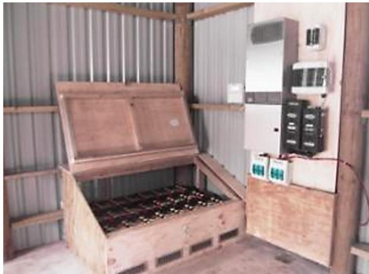
**Figura A.9:** Banco de baterías dentro de un cajón con ventilación
