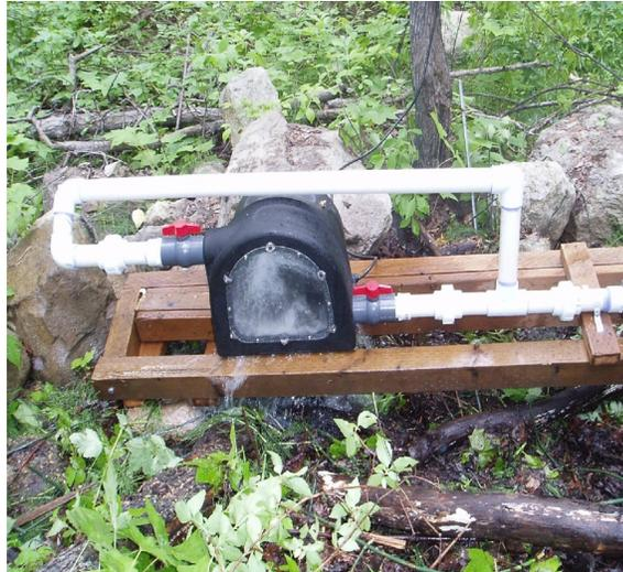
**Figura A.8:** Ejemplo de fijación de la base de la turbina
