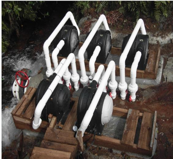
**Figura A.7:** Ejemplo de fijación de la base de la turbina
