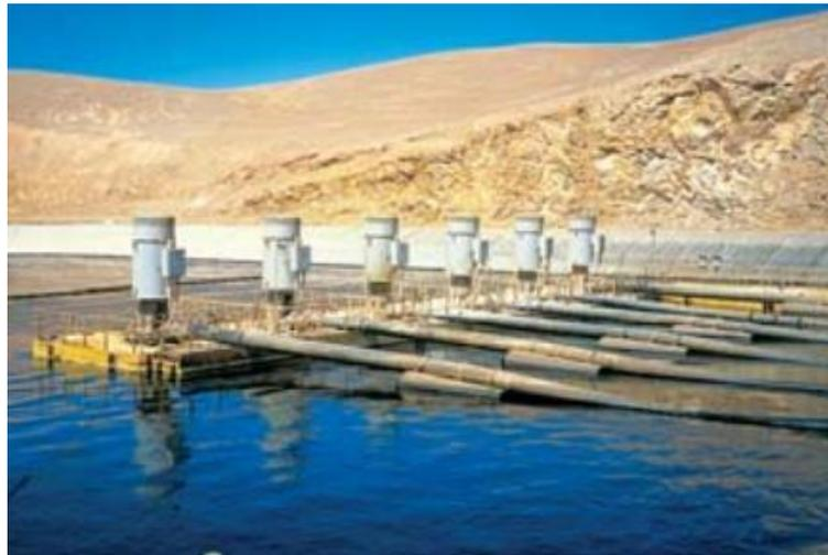
Figura 5.7. Bombas Hazleton en piscina de refino superior
