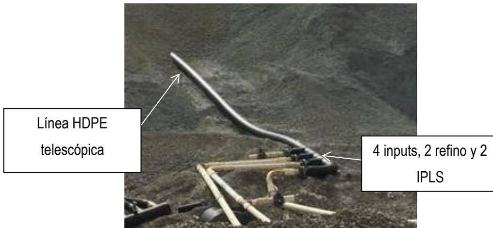
Figura 5.14. Unión efe a línea que va sobre la pila
