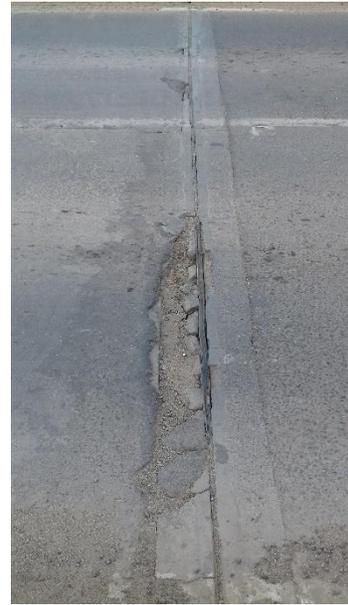
*Figura 4-5 Junta de expansión rota*
