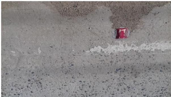
*Figura 4-4 Decoloración línea en la vía*
