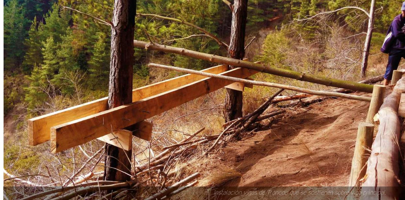
*Instalación vigas de Troncos que se sostienen sobre viga principal.*
