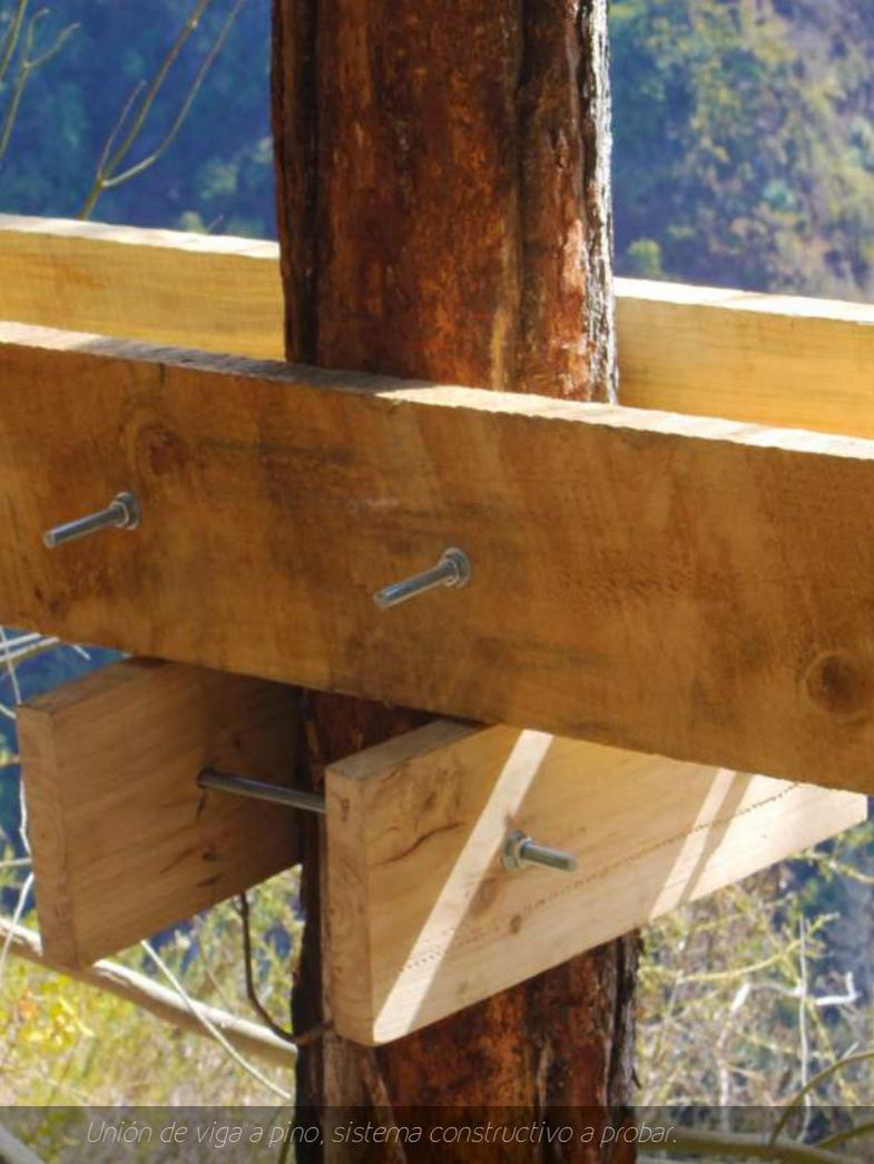
*Unión de viga a pino, sistema constructivo a probar.*
