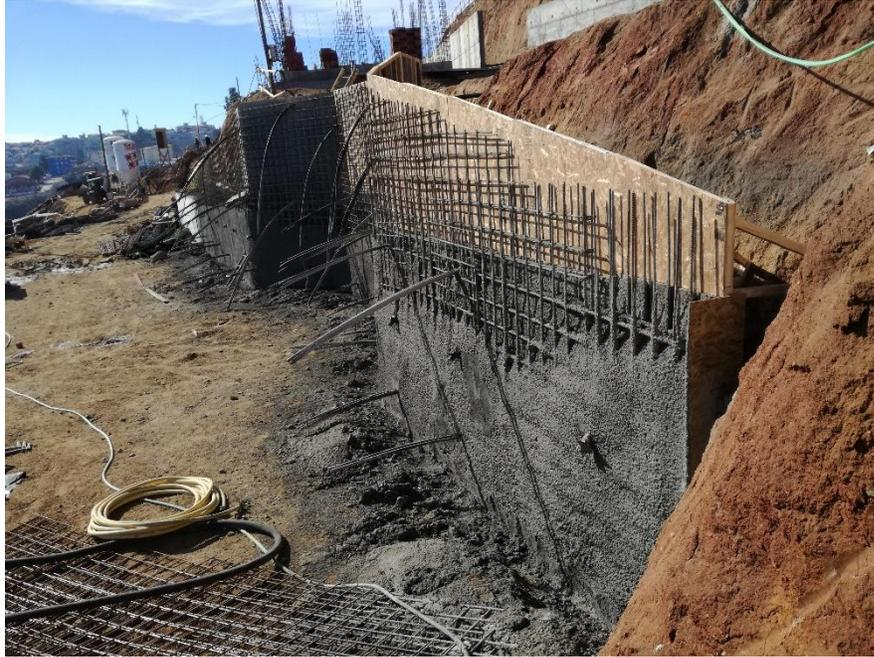
*Figura 3.1.9. Ejecución muro atirantado.*
