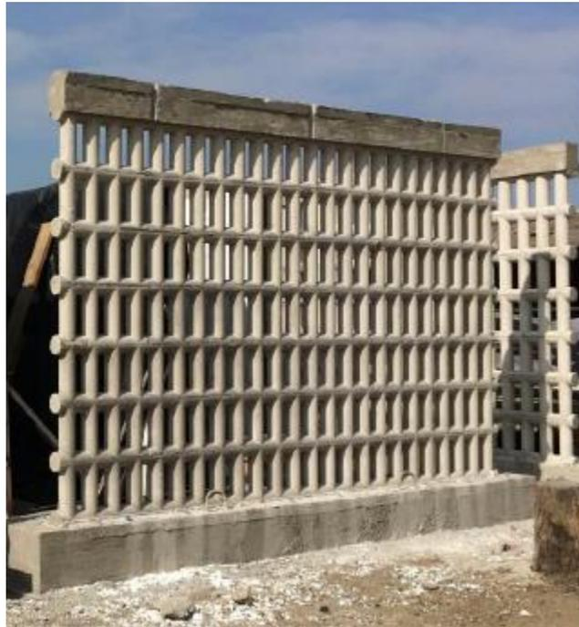
*Figura 2.1.2. Interior de hormigón armado de los paneles.*
