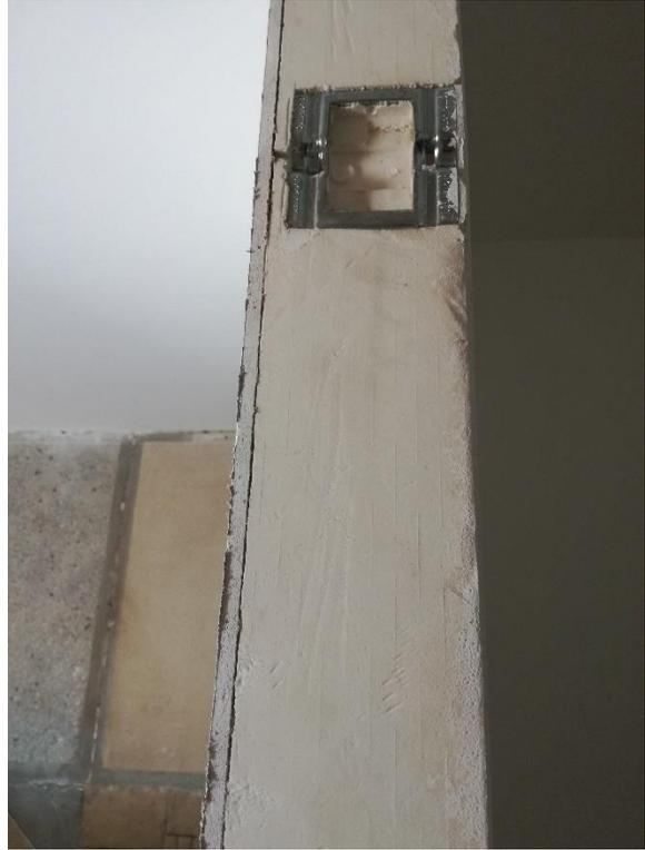
*Figura 2.2.2. Detalle sistema de anclaje.*
