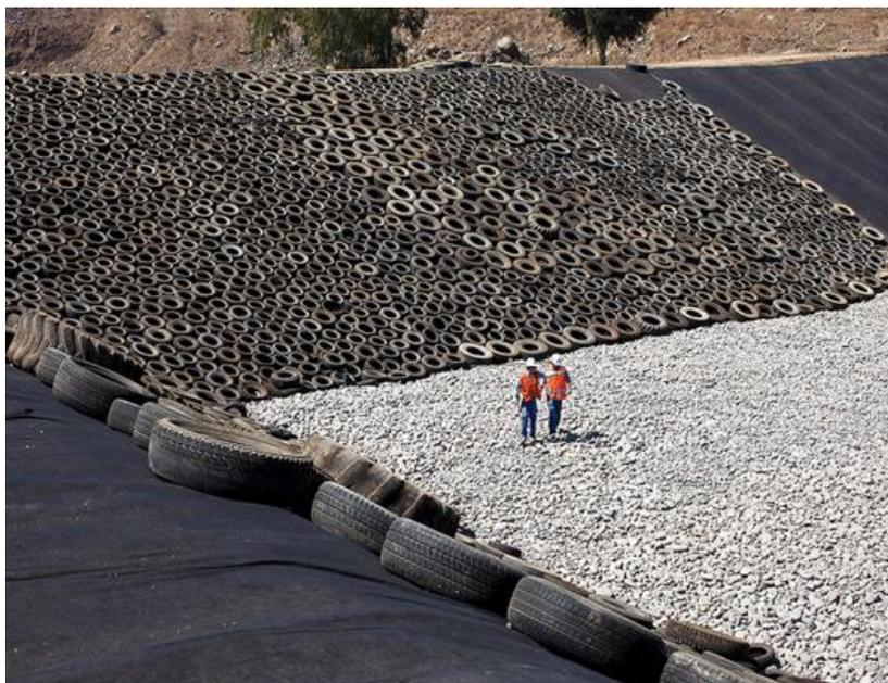
**Figura 3.9** Etapa de construcción de un relleno sanitario por la empresa Veolia para el depósito de desechos domiciliarios [30].
