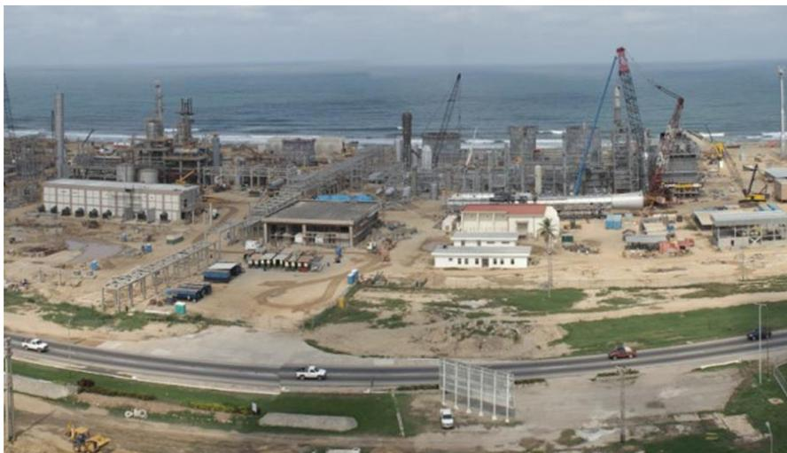
Figura 1-10: Montaje electromecánico del complejo petroquímico de amoníaco y urea
