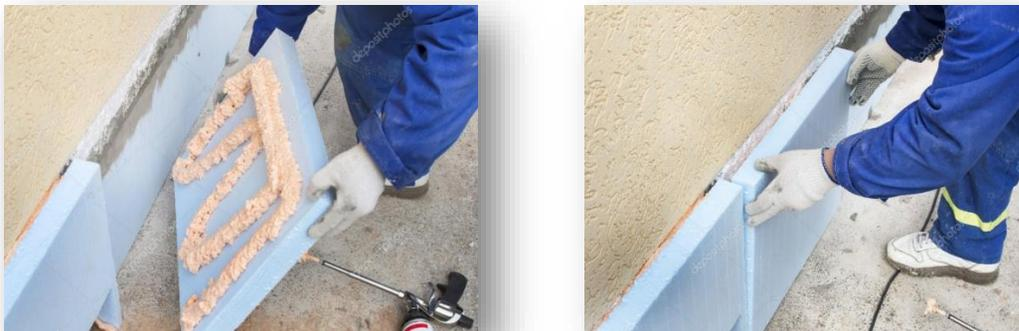
**Figura N°16:** Pegado de planchas de poliestireno.
