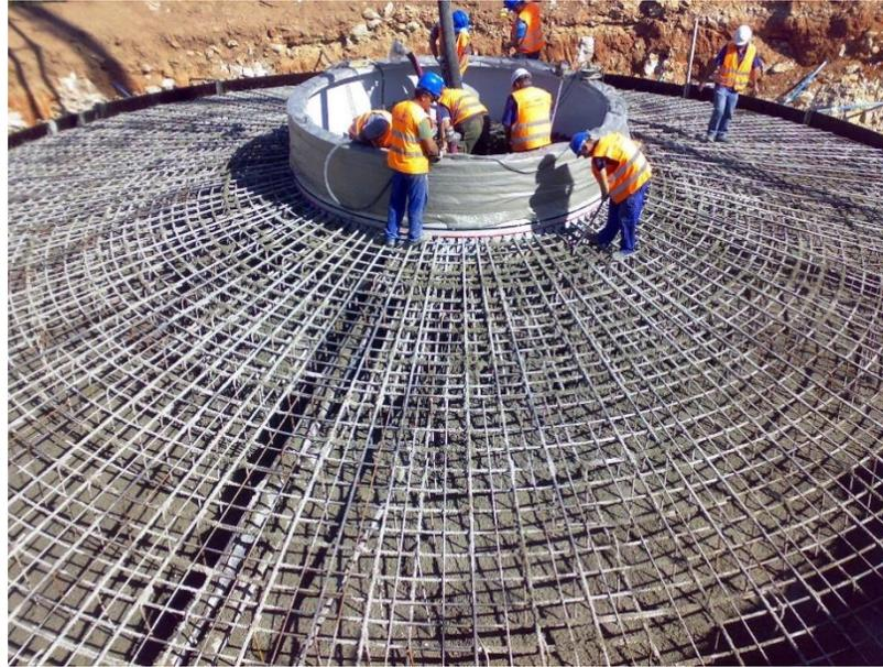
Fuente: cimentaciones prefabricadas en aerogeneradores
