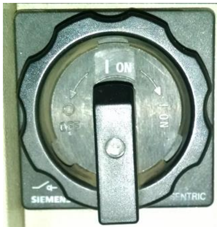
Figura 2.1 Interruptor en Encendido
