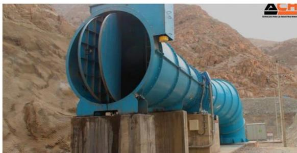
Figura 1.8: Manga de ventilación rígida utilizada al exterior de la mina
