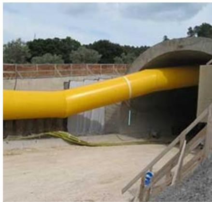
Figura 1.9: Manga de ventilación flexible lisa puesta en la entrada de un túnel.
