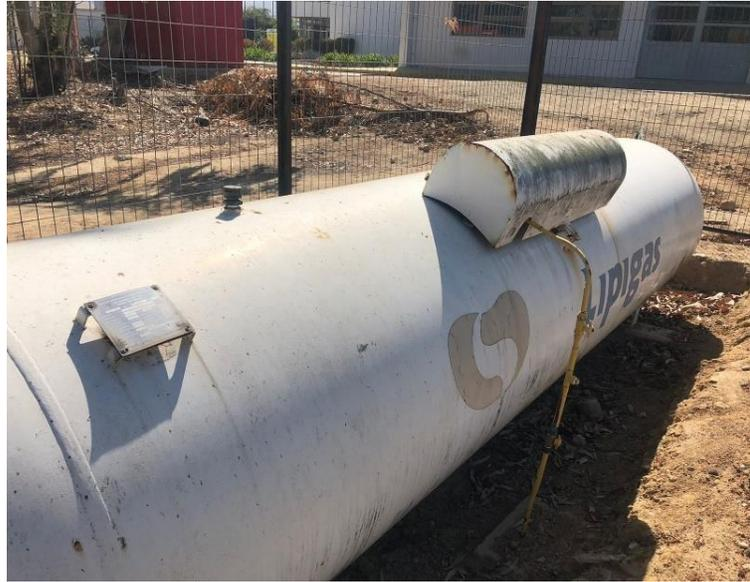
*Figura 3.13: Tanque de alimentación de GLP.*
