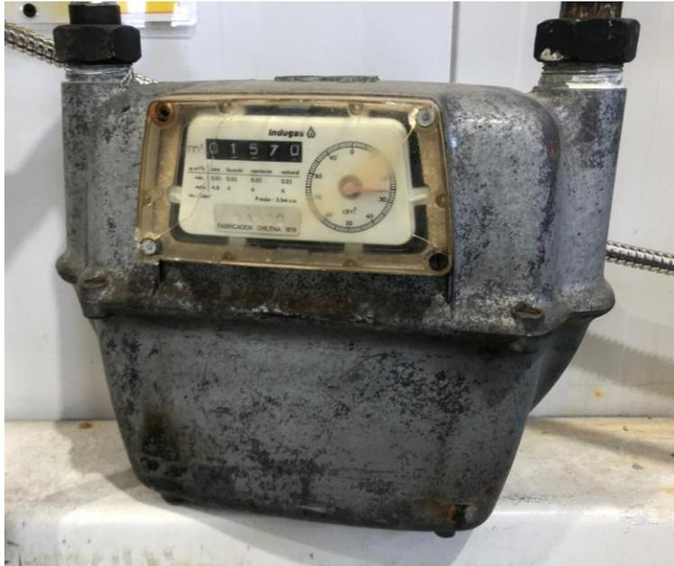
*Figura 3.14: Medidor de consumo para GLP.*
