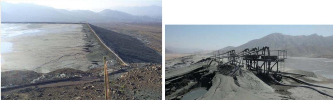
*Ilustración 10. Distribución de Relaves mediante ciclones*
