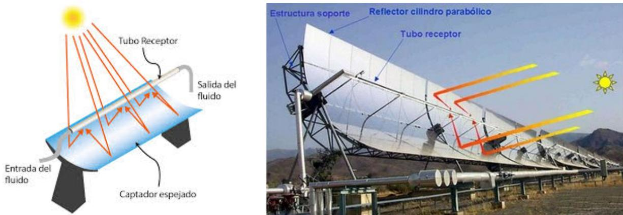
Figura 1.7: Colectores Cilindro Parabólicos
