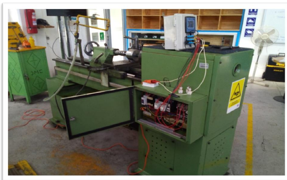
Figura 2. 14. Analizador de red conectado a la máquina en el ensayo.
