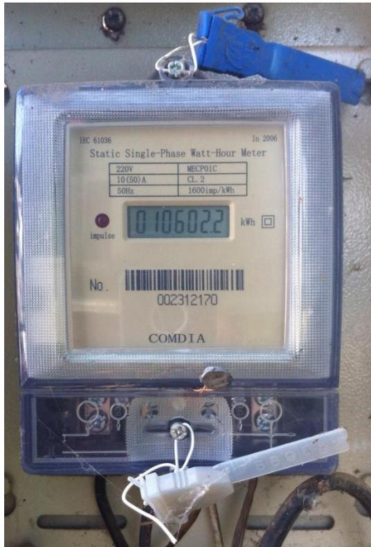
*Figura 18, Medidor electrónico.*
