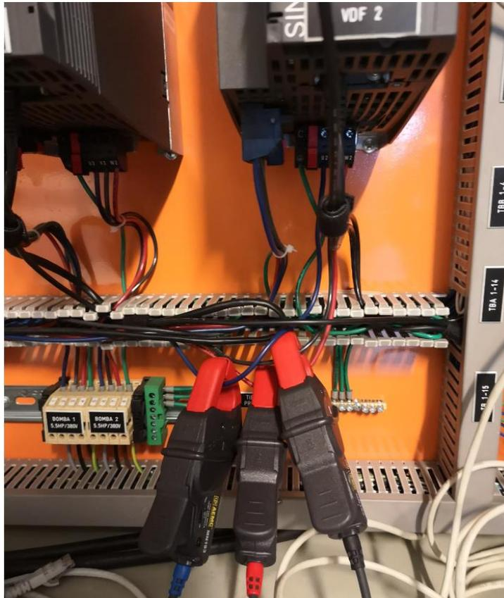
Figura 6-37: Pinzas de corriente del analizador de redes para las 3 fases.
