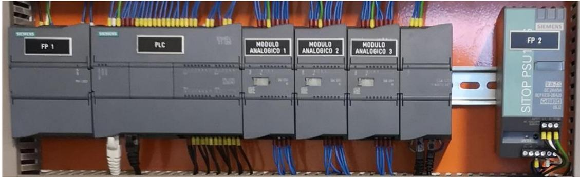
Figura 3-16: Tablero de control del PLC, 2 fuentes de poder, 3 módulos analógicos y switch ethernet.
