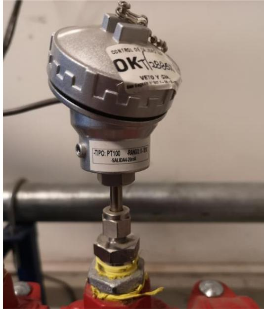
Figura 3-11: Sensor de Temperatura tipo PT100.
