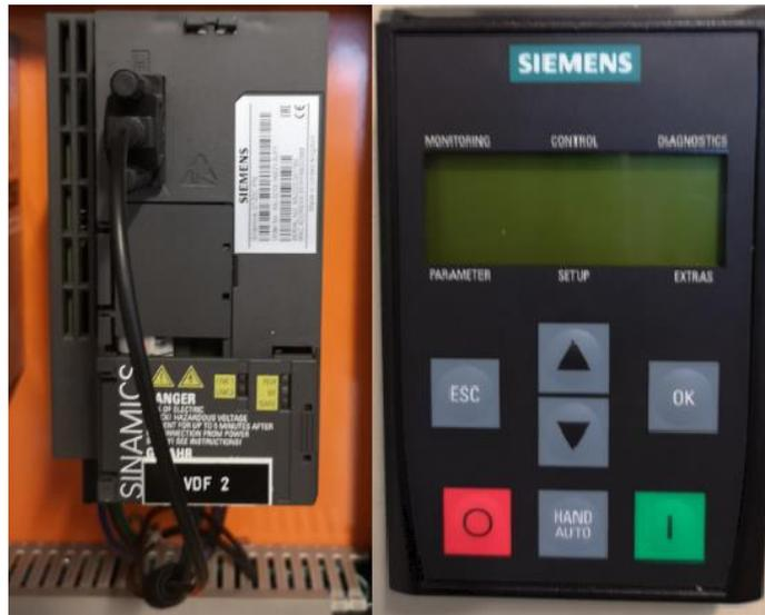
Figura 3-13: Variador de frecuencia (izquierda), junto con su comando (derecha)
