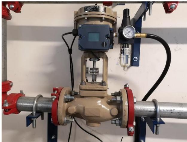
**Figura 3-5: Válvula de estrangulación Samson 3277.**
