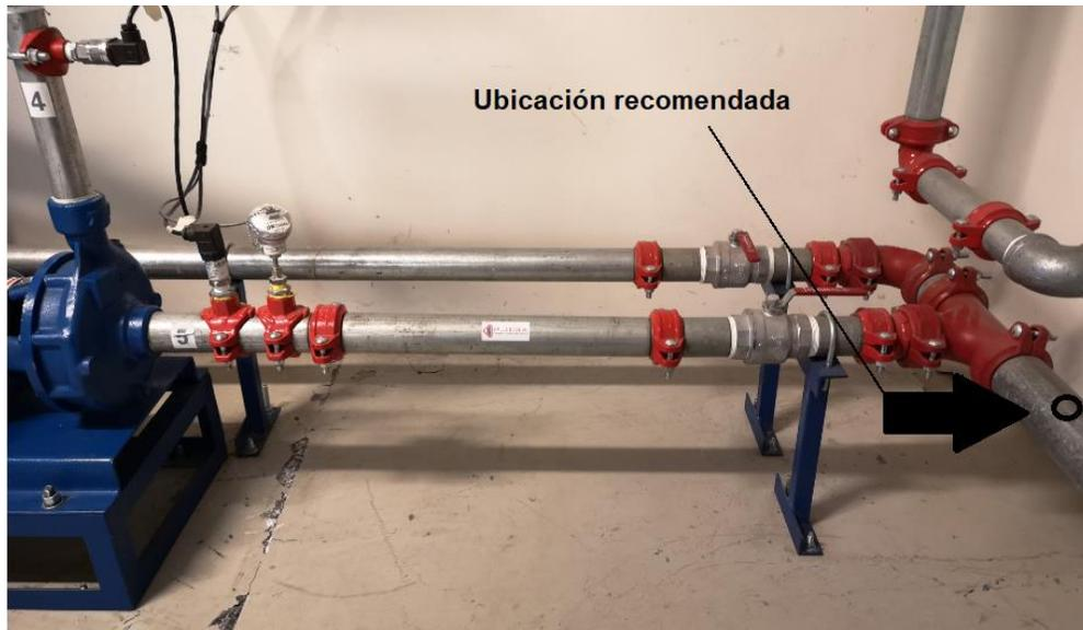
Figura 5-1: Lugar de ubicación recomendada para el sensor de temperatura según la alternativa 1.
