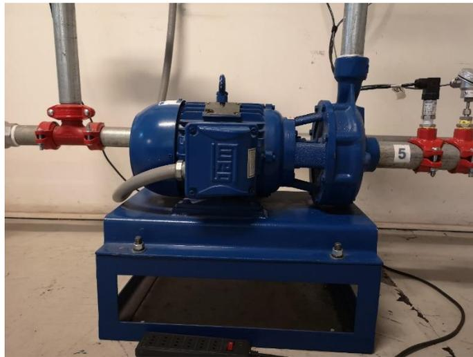
Figura 3-2: Bombas Centrífuga Vogt H620, junto con su motor eléctrico Weg W-22(Vista Lateral).
