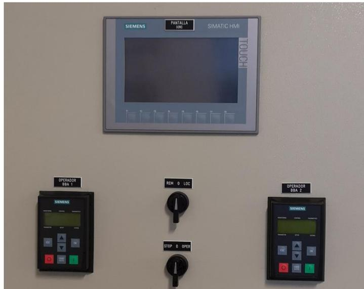
Figura 3-17: Pantalla HMI juntos con los controladores de ambos variadores de frecuencia.
