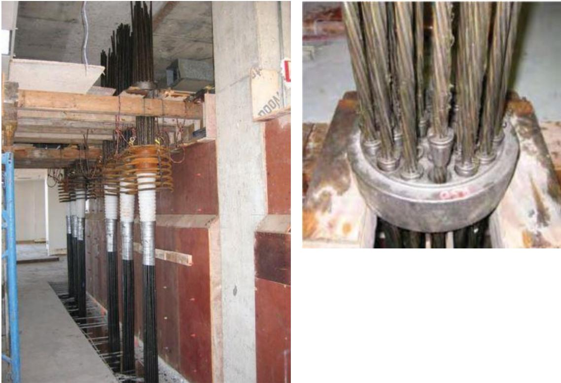
Figura 2-10: Tendones de cables postensados [8]
