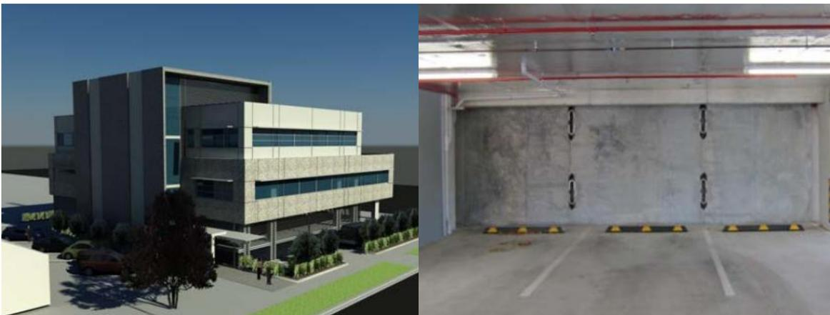
Figura 2-14: (Izquierda) Edificio Southern Cross Hospital. (Derecha) muros mecedores nivel estacionamientos.
