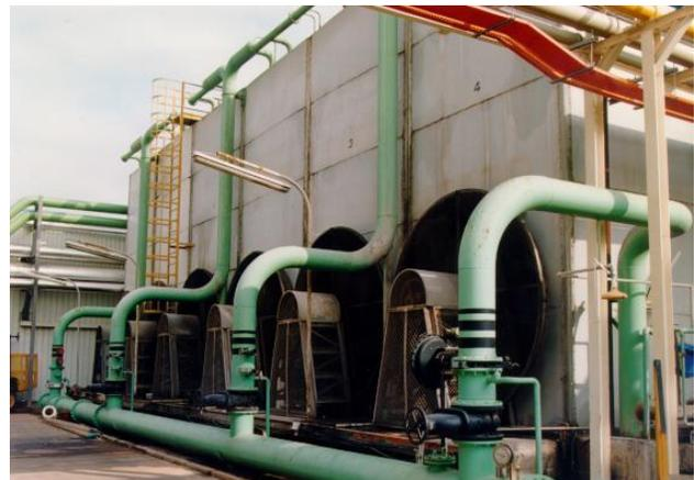
Ilustración 3-11: Torre de refrigeración de tiro forzado.
