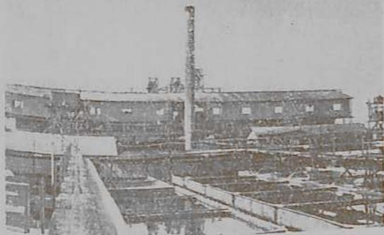
Fig. 4.—Cristalización del salitre, según Shanks.
