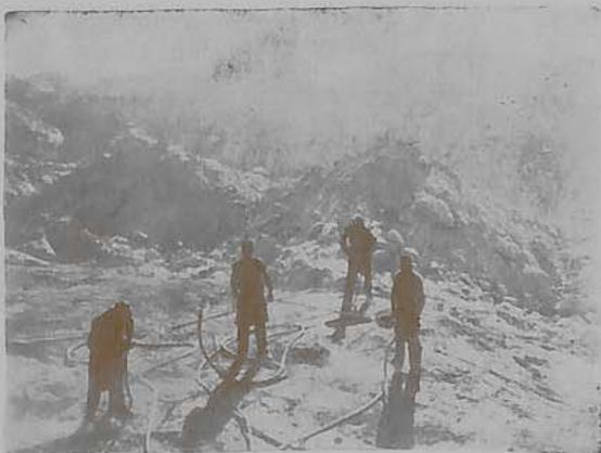
Fig. 5.—Explotación de la mina, según Guggenheim. Perforistas con máquinas neumáticas.
