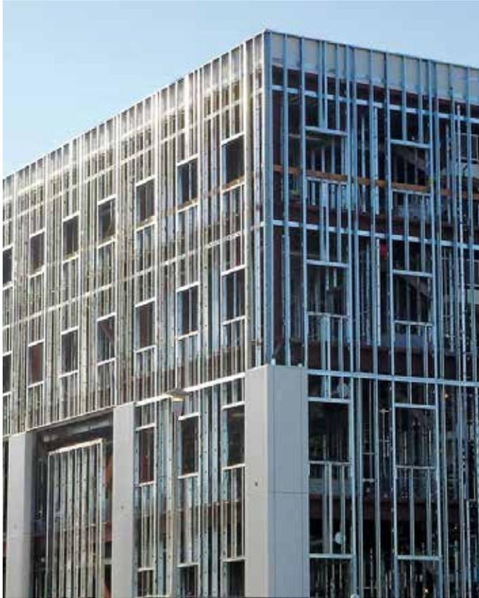
Finalmente es factible edificar en altura con este sistema constructivo, alcanzando más de 12 niveles utilizando uno o dos niveles en hormigón armado y hasta 6 niveles únicamente en estructura de acero liviana.
