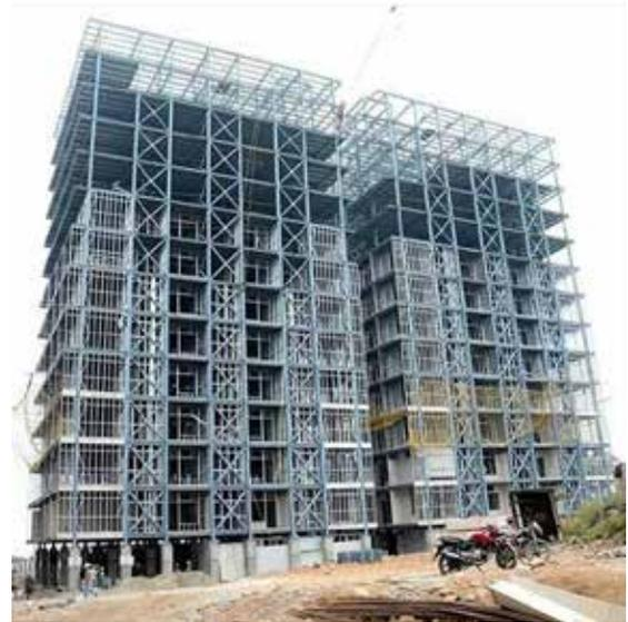
De este modo se determina que el sistema constructivo a utilizar para elaborar el proyecto de Vivienda Colectiva es el Metalcon o estructura en acero liviano, siendo el único presente en el mercado actual capaz de ser transportado sin mayores dificultades hasta la isla, con faenas de corta duración, capaz de edificar en la altura que el proyecto requiere y con la posibilidad real de que los pobladores los interioricen y utilicen en el futuro
