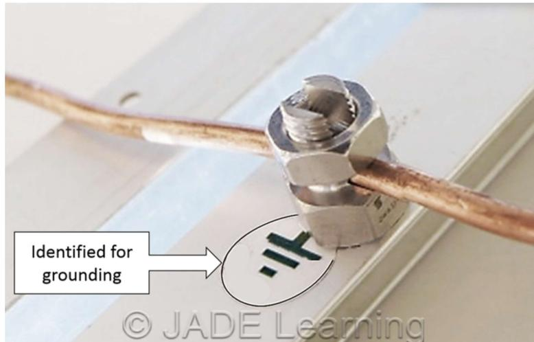
**Figura 6.20:** Instalación de toma a tierra del panel fotovoltaico.
