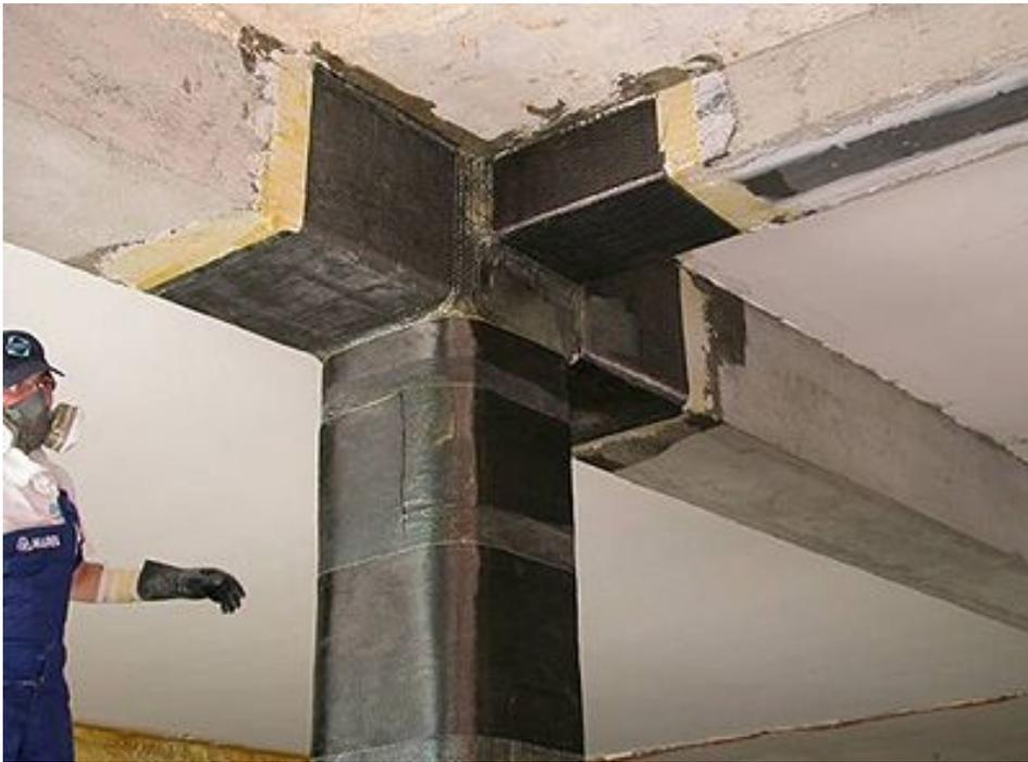
Figura 2.7. Refuerzo estructural de corte con tejidos de CFRP en vigas y de confinamiento en las columnas (fuente: Sika S.A.).
