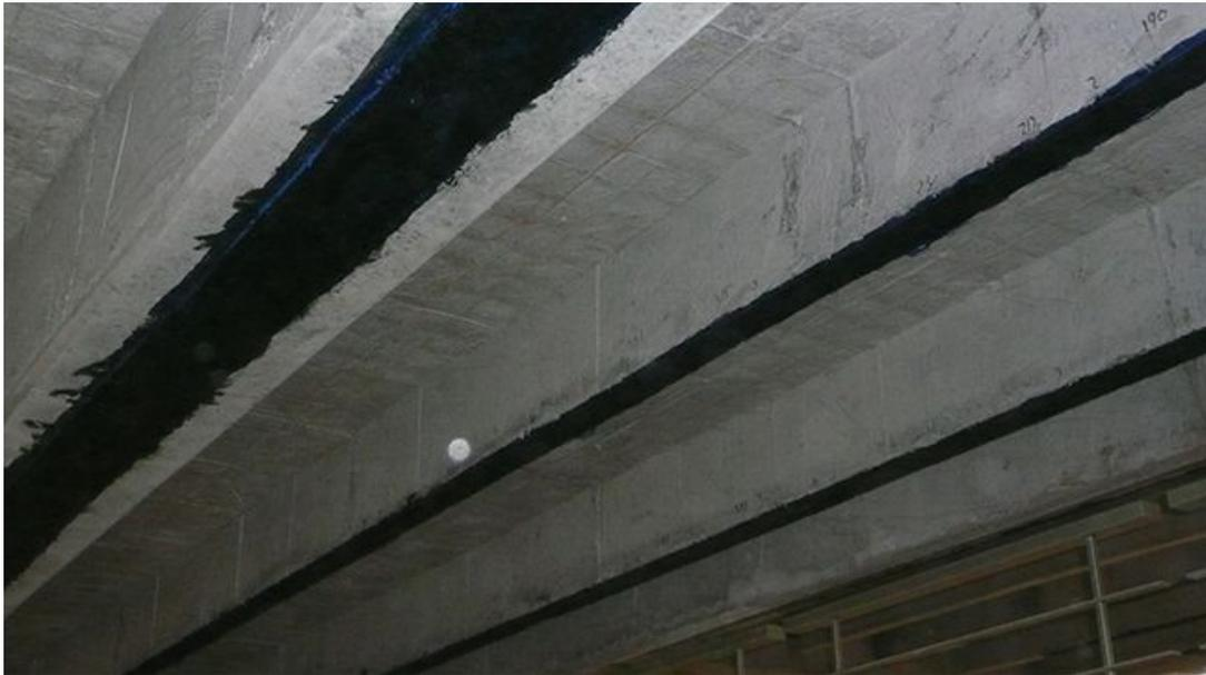
Figura 2.5. *Refuerzo estructural por flexión con pletinas de CFRP en vigas (fuente: Sika S.A).*
