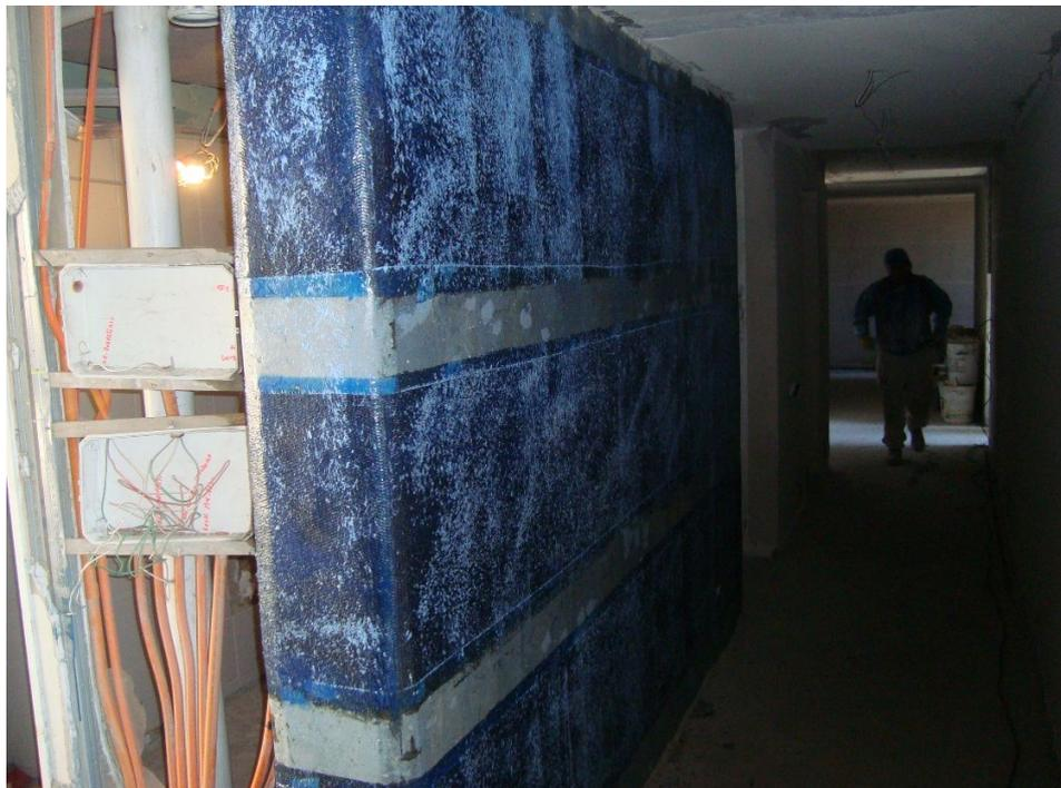
Figura 2.6. Refuerzo estructural de corte con tejidos de CFRP en muros (fuente: IE3 Ingeniería Estructural).
