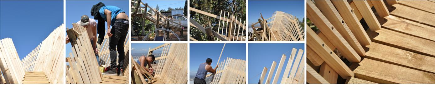
**9.- DETALLES (CANTEADO Y LIJADO DE LOS ELEMENTOS DE BORDE CORTANTE)**
