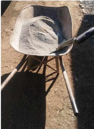
3. Luego de tener mezclado tanto arena, escoria y cemento se adiciona la grava previamente dosificada en masa, esta cubre todo el material fino formando una capa de grava como se muestra en la siguiente imagen, a continuación se vuelve
