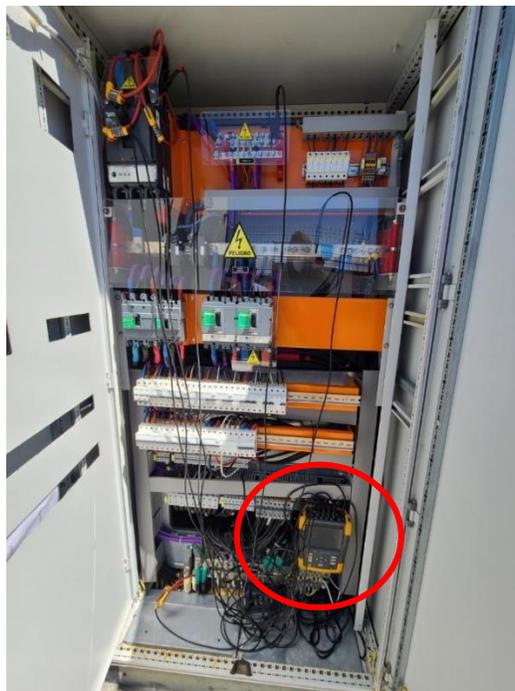
FIG. 25 FOTOGRAFIA INSTALACIÓN ANALIZADOR DE RED FLUKE [FUENTE : ELABORACION PROPIA ]
