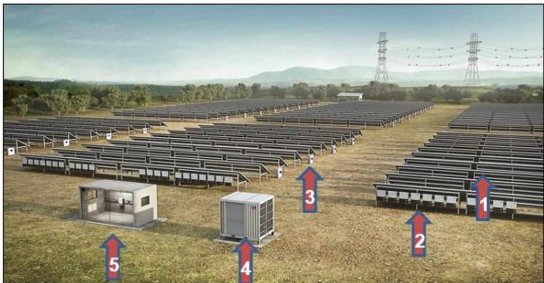
*Ilustración 14: Esquema general de un sistema de inversores descentralizados. [7]*
