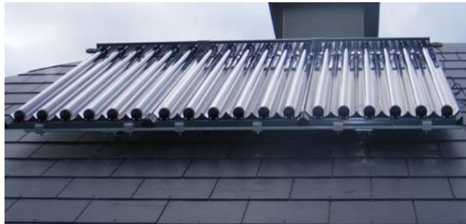
Figura 2.7: Colectores parabólicos compuestos
