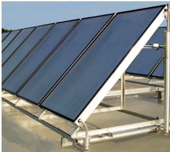
Figura 2.5: Colector de placa plana
