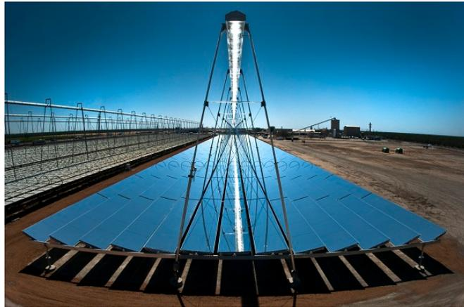
Figura 2.9: Reflector de Fresnel lineal
