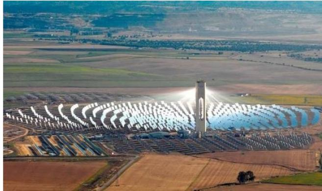
Figura 2.11: Colector de campo de helióstato
